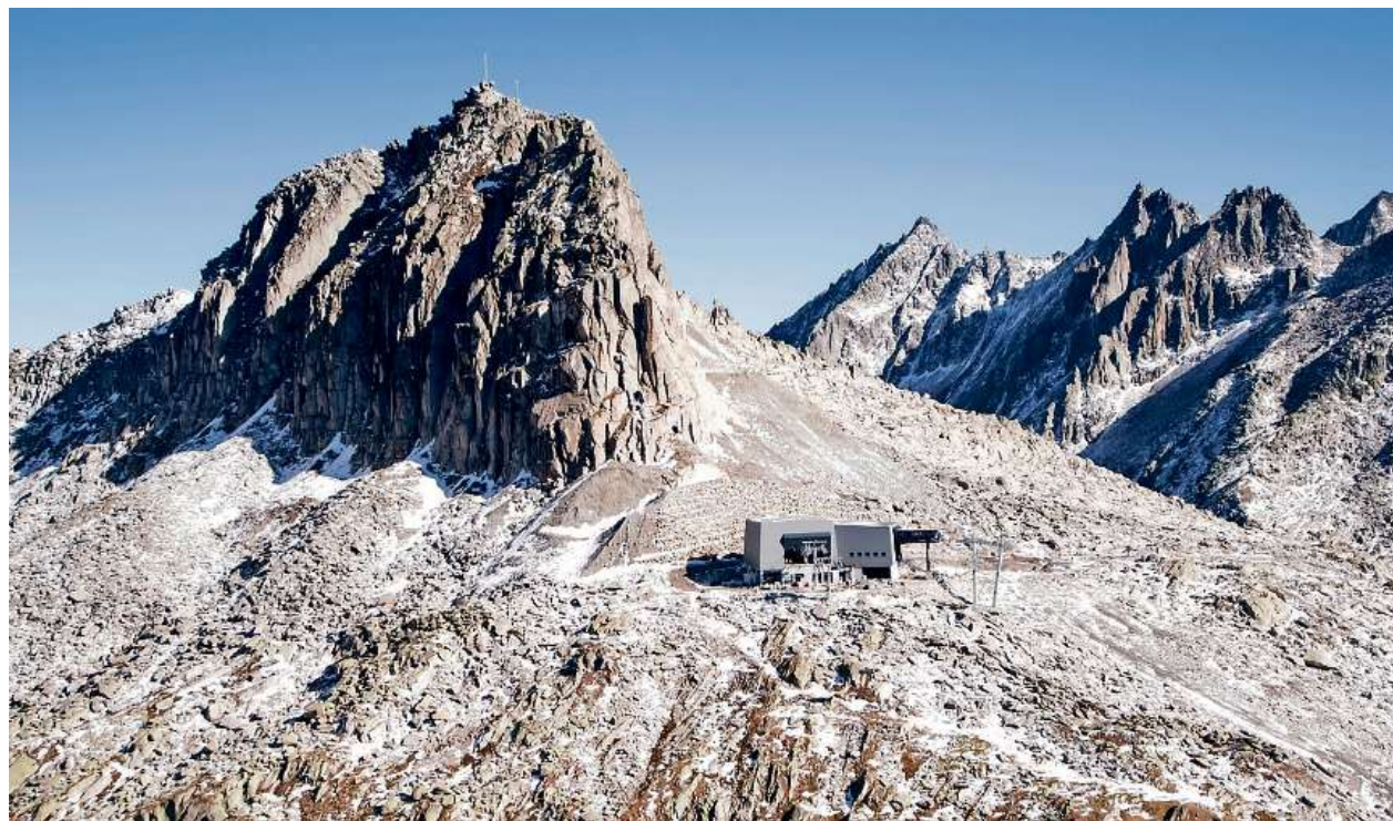
Letztes Puzzle-Stück: Läuft alles nach Plan, können Wintersportler ab der kommenden Saison in beiden Richtungen zwischen den Skigebieten Andermatt und Sedrun wechseln.
